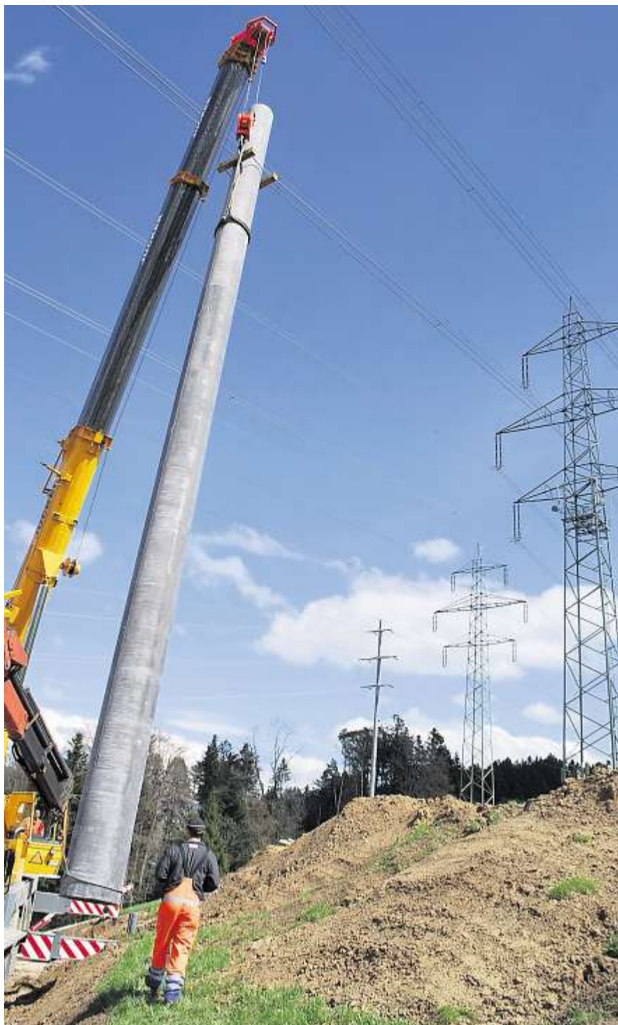
Ein Spezialkran hebt den neuen Mast und senkt ihn ins Fundament. Bild: Fredy Stäheli
